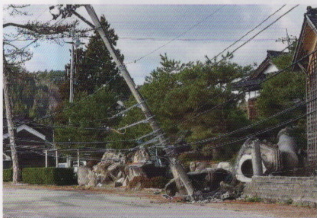
被災地の被害状況
